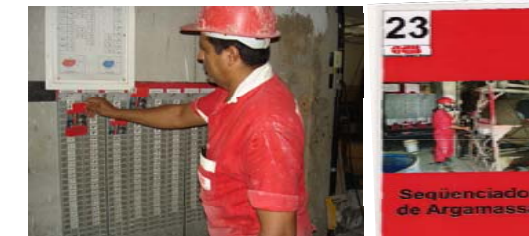
Acima, podemos ver o betoneiro Geraldo controlando o seqüenciador de argamassas
